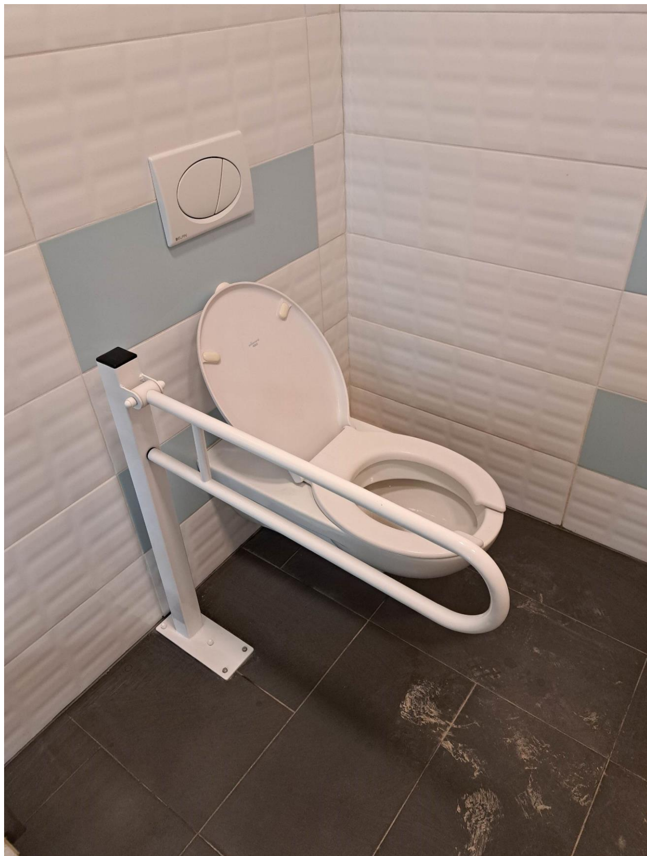
Toaleta dla niepełnosprawnych
