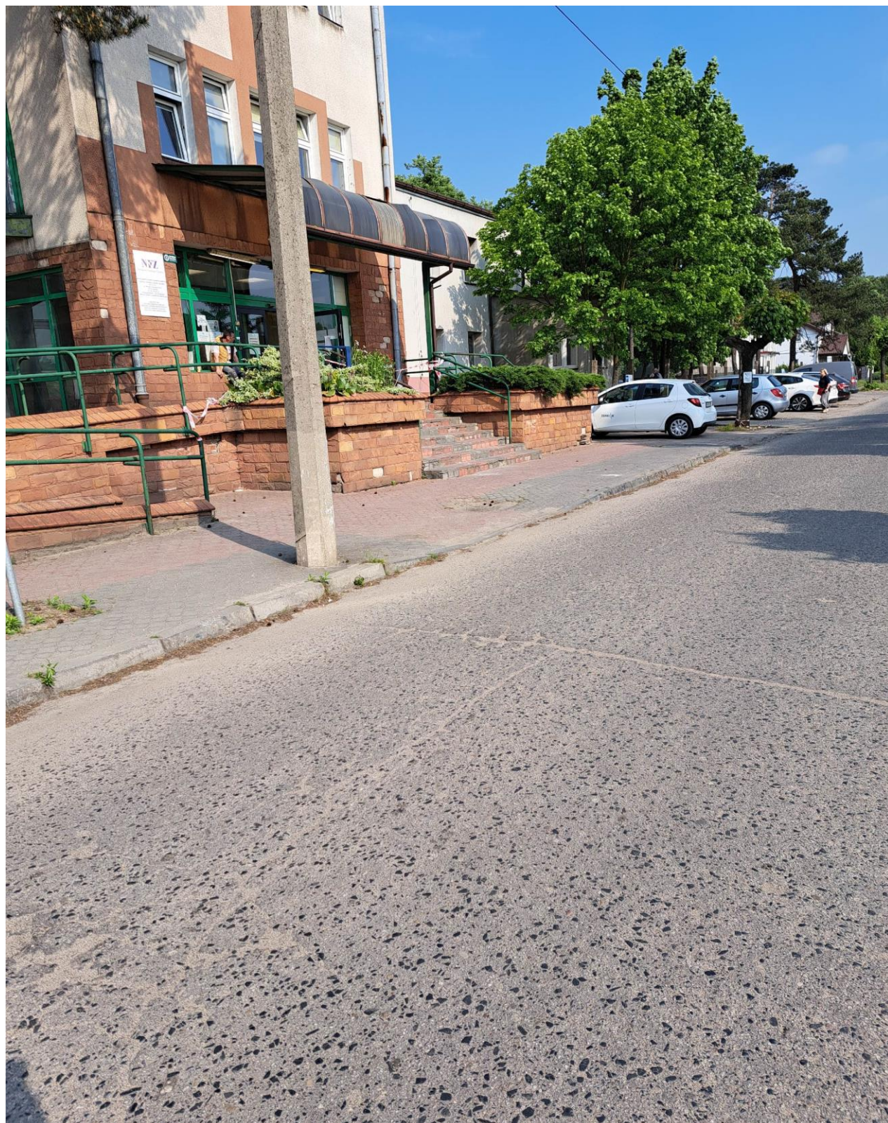
Dojście do budynku
