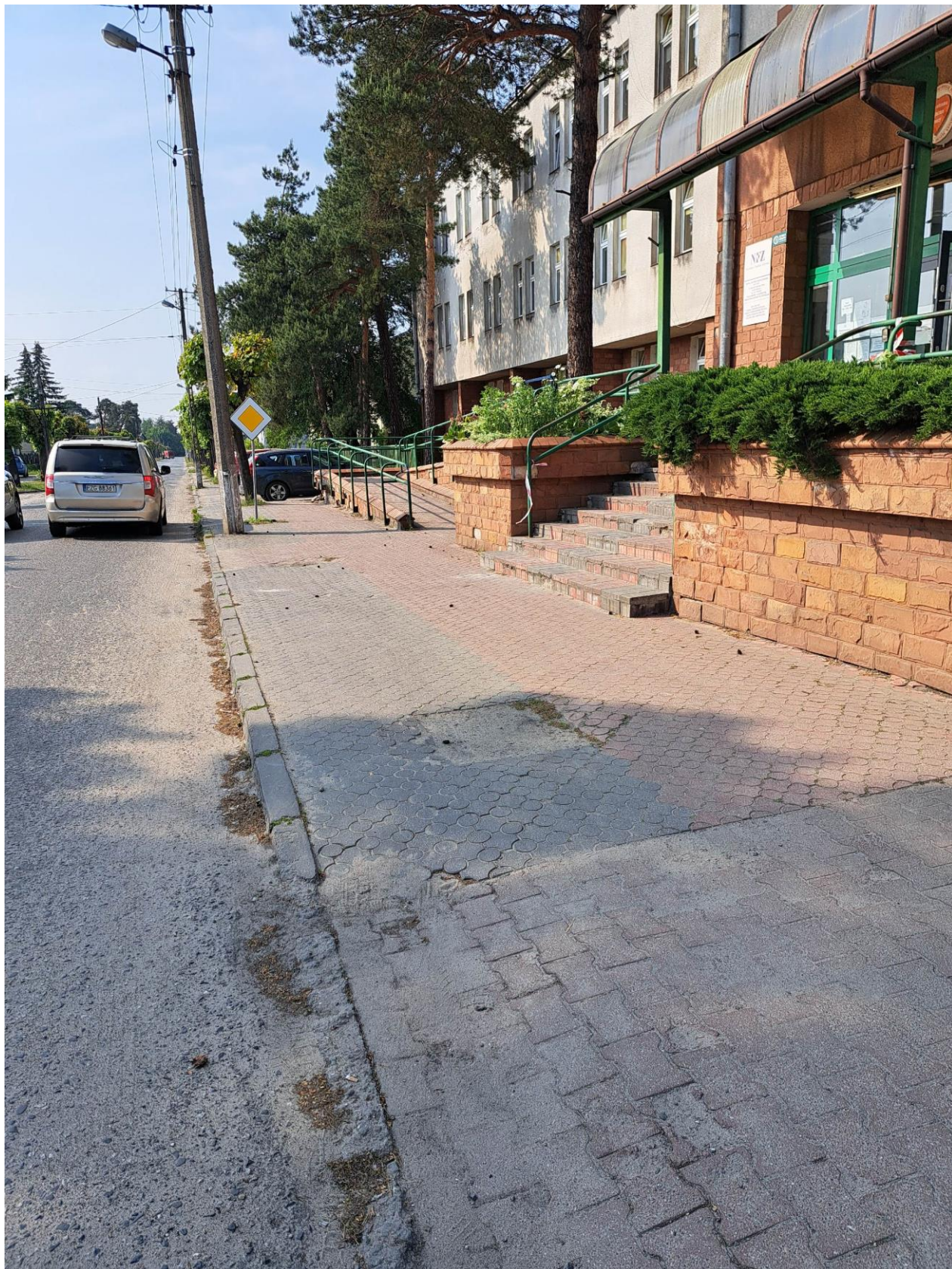
Dojście do budynku
