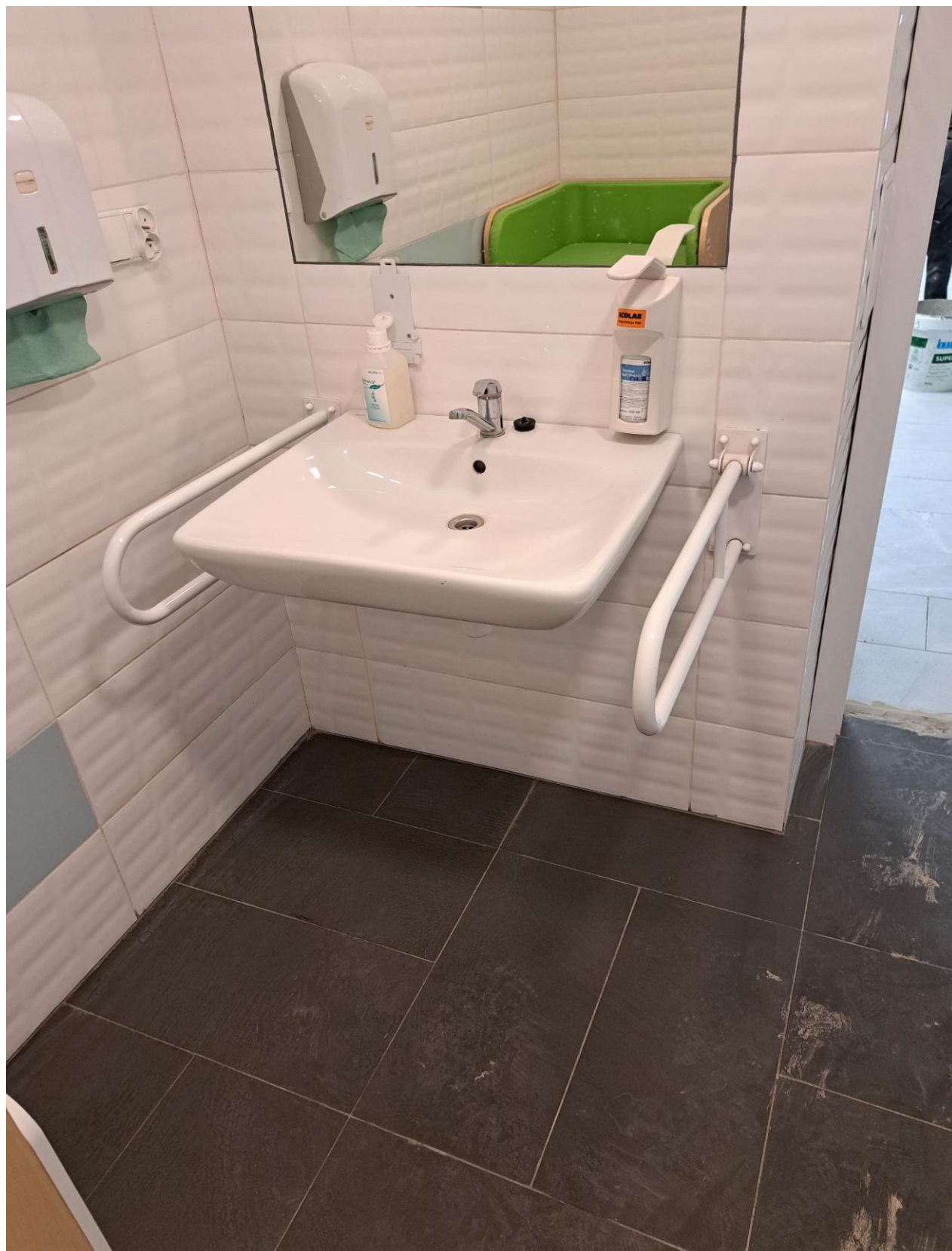
Toaleta dla niepełnosprawnych
