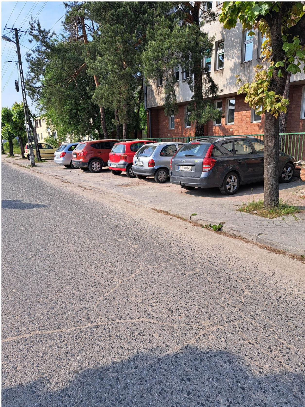
Dedykowane miejsce parkingowe dla osób niepełnosprawnych
