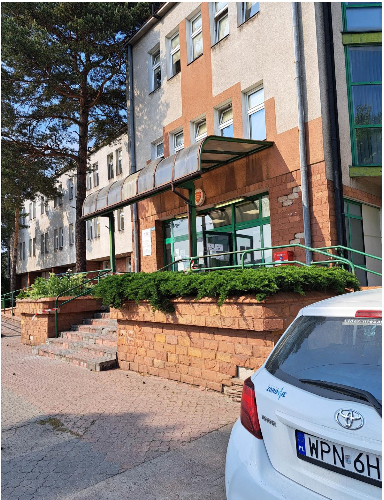
Dojście do budynku
